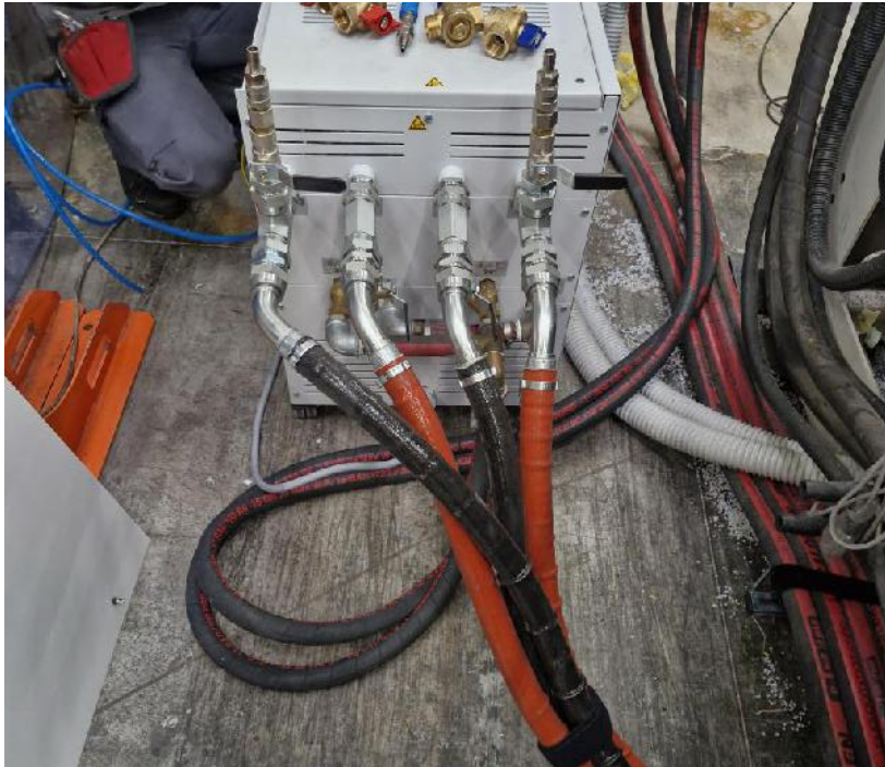
TCU mit zwei Kreisläufen bei 180°C. PTFE-Schläuche mit Glas-Silikon-Ummantelung, Edelstahlaraturen und Entleerungssystem.
